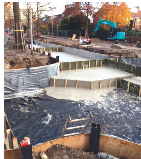
Lavoro eseguito in Germania da Faber Betonpumpen
