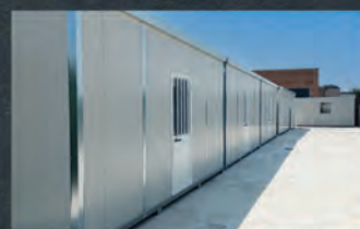
Dormitori da cantiere
