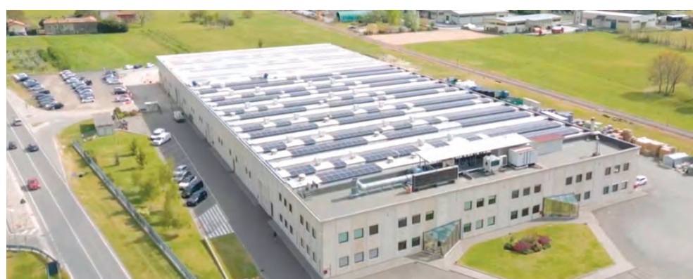
Lo stabilimento Ergotech a Montestrutto (TO)
