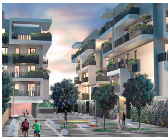
Primo complesso residenziale certificato Active House PRO al mondo - Giardino delle Gemme, Monza - Foto di Matteo Piazza (Milano)
