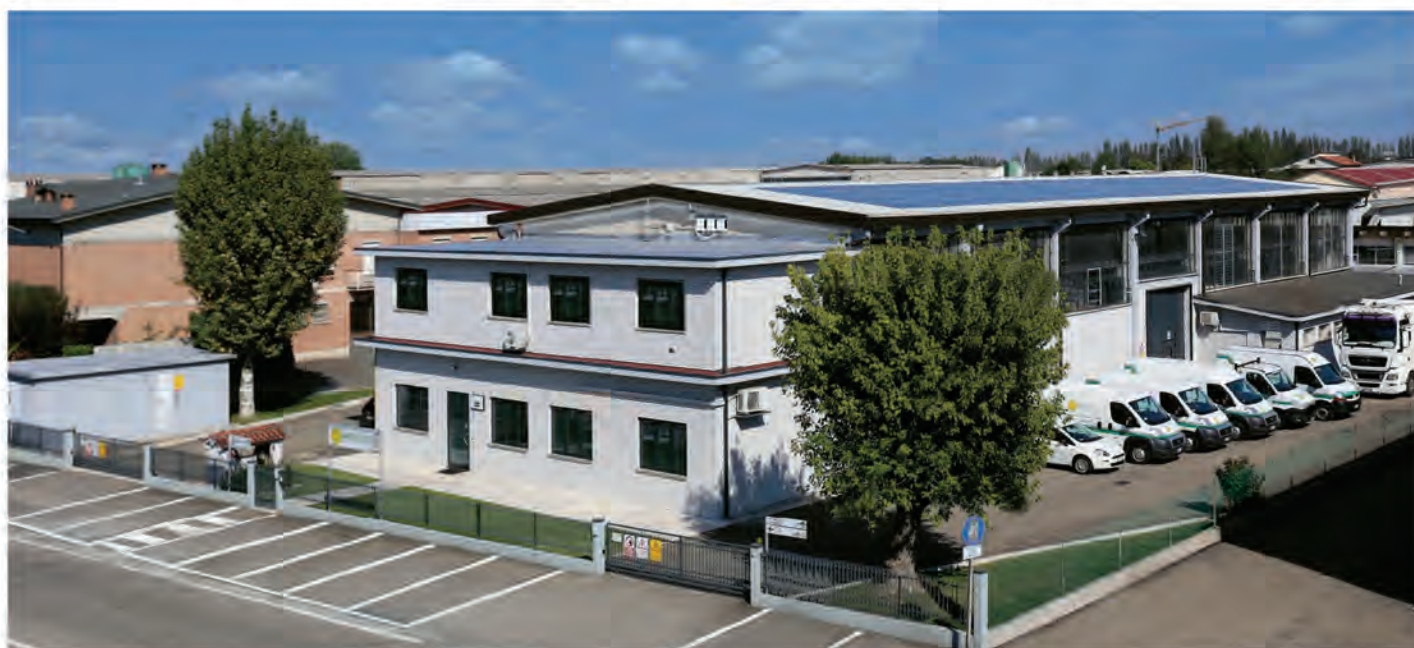
LO STABILIMENTO DI CAMPOGALLIANO (MO)
