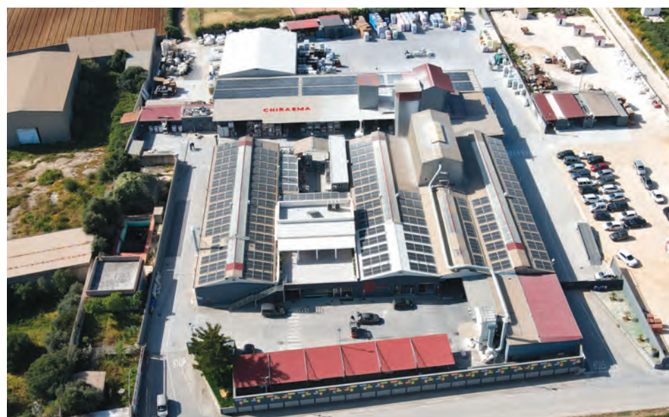
Impianto Fotovoltaico B2B www.a29srl.it
